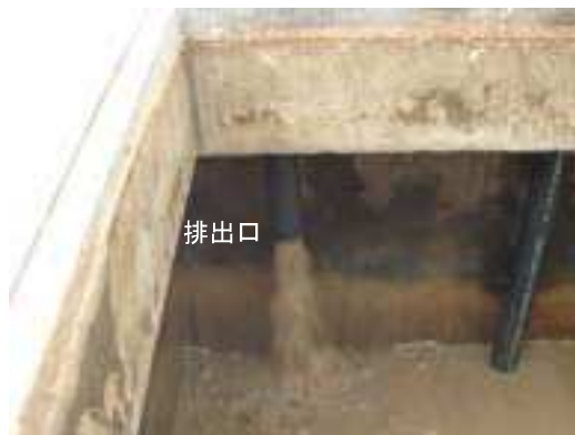
写真1 散気管洗浄の様子
